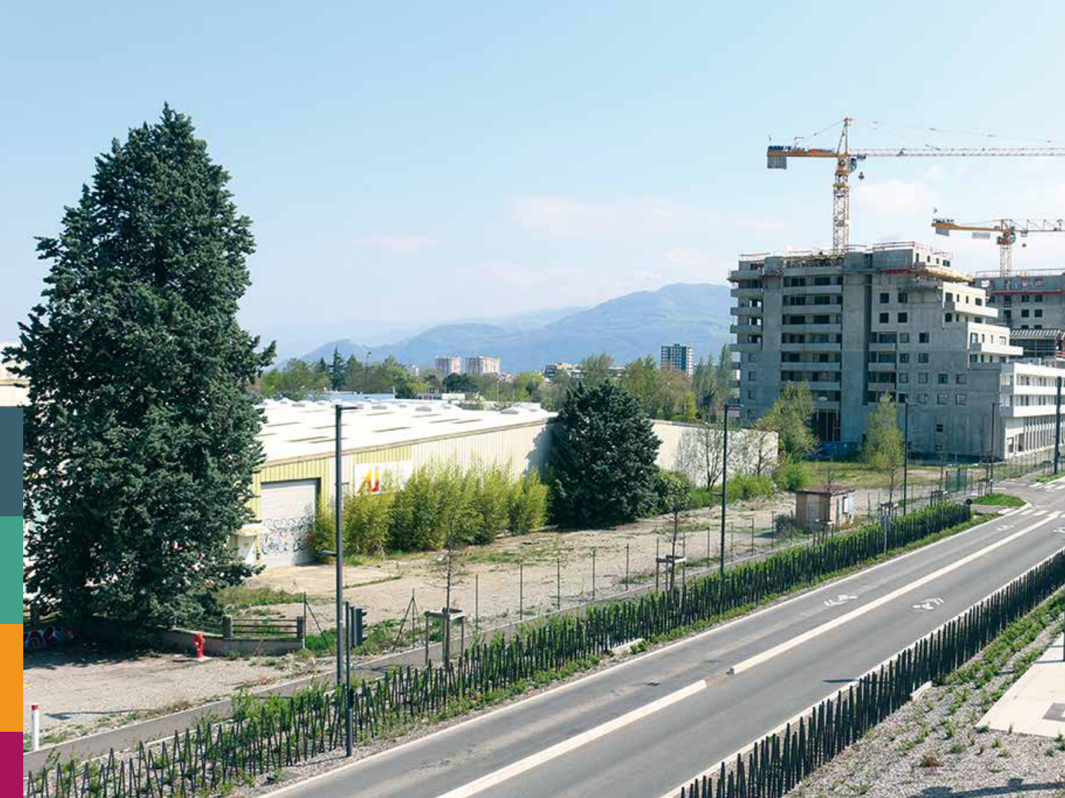
Le long de l'avenue Charles de Gaulle, une résidence intergénérationnelle verra le jour en 2024 (plus d'infos p.15)
