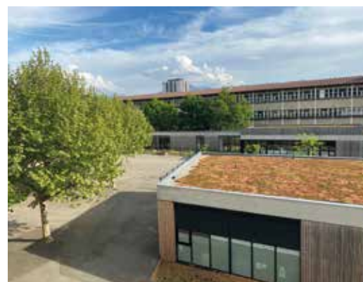
Rénovation du sol au plafond
