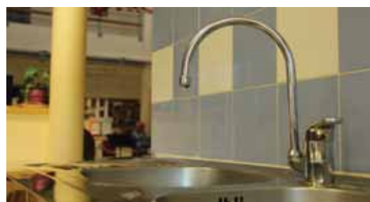
Rénovation du réseau d'eau à la résidence pour personnes âgées
