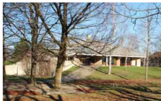
Rénovation de la chaufferie du centre aéré
