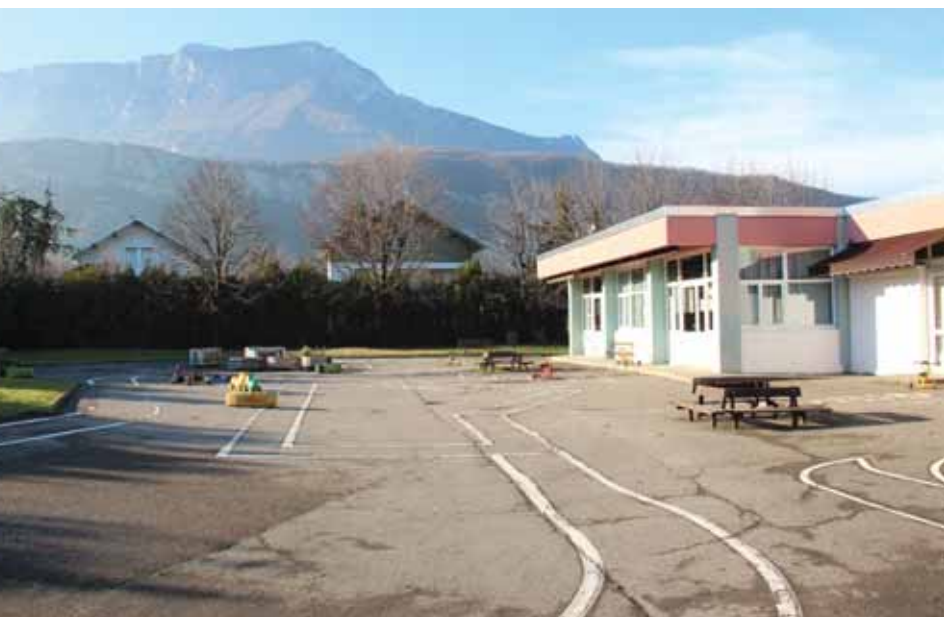
Ecole des 120 toises, un nouvel aménagement de la cour prévu.
